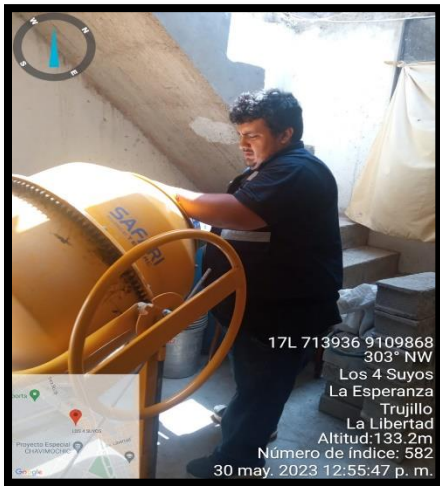
FOTOGRAFIA N°20 Uso de una mezcladora pequeña para la realización del concreto para los especímenes
