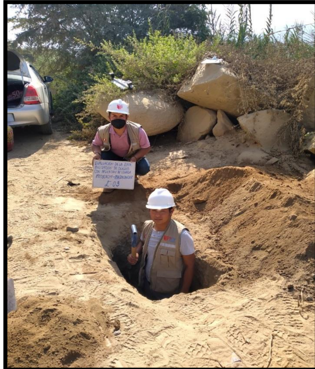
Calicata 3 y toma de muestras
