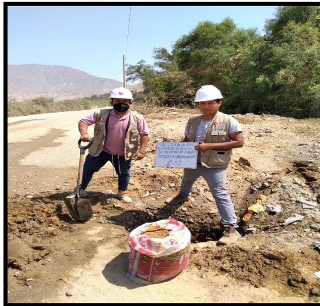
Calicata 2 y toma de muestras
