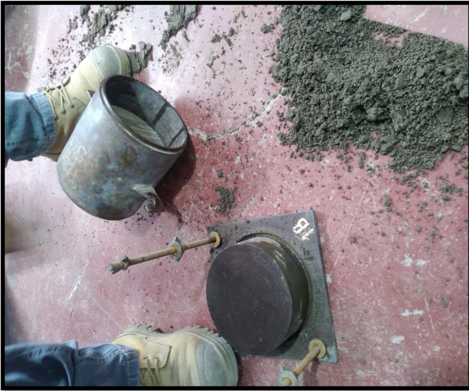
Colocación de placa de base para Proctor.
