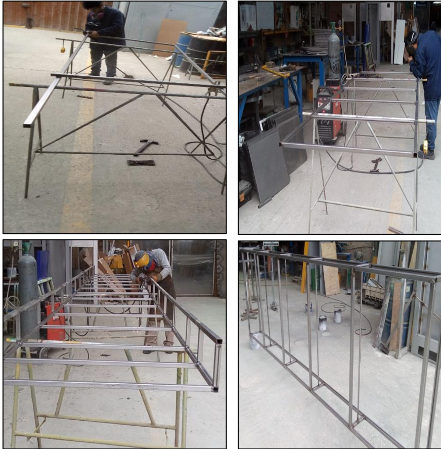
Figura 28: Proceso de soldadura para la fabricación de paneles publicitarios
