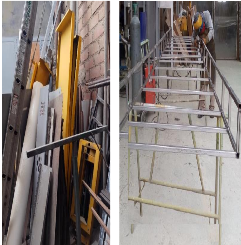
Figura 6: Área de Soldadura
