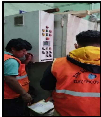
Figura 41: Inspección del horno eléctrico
