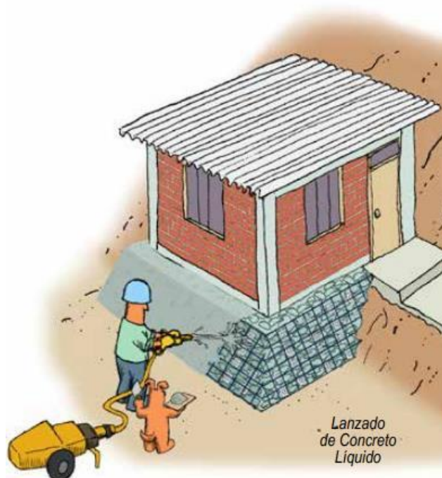
LANZADO DE CONCRETO LIQUIDO
