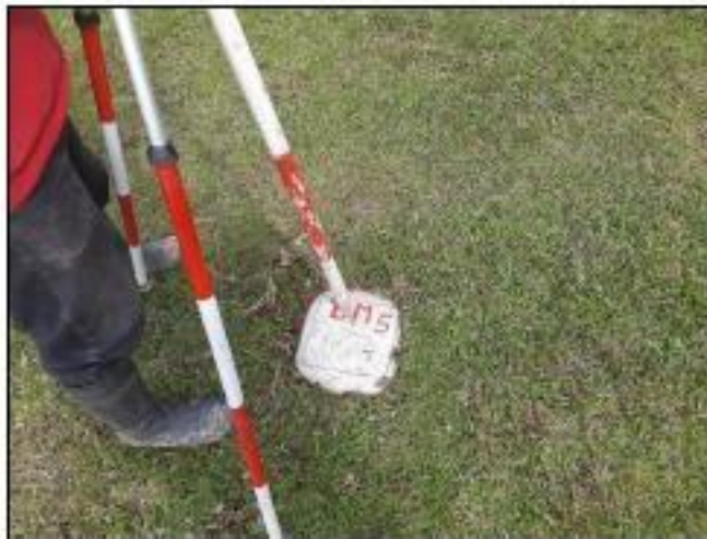
TOMA N° 04: Levantamiento topográfico de la franja de línea proyectada
