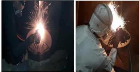
Figura N°13: Fotos del metalizado
