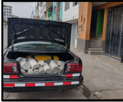
Figura 12. Recojo y transporte del concreto reciclado
