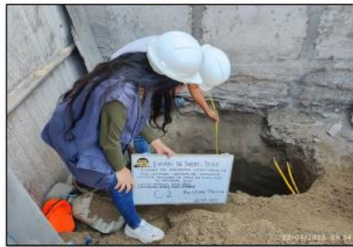
CALICATA C-2 VISTAS DE ESTRATIGRAFIA
