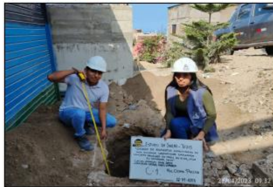
CALICATA C-1 VISTAS DE ESTRATIGRAFIA
