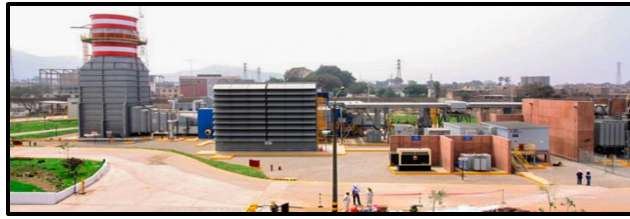
Figura 2. Central Termoeléctrica Santa Rosa.
