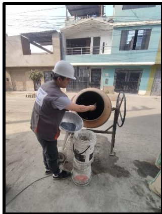
Agregando los agregados al concreto
