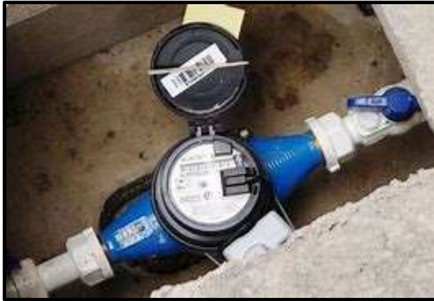
Figura N° 04: Conexión domiciliaria (Fuente Sedapal)
