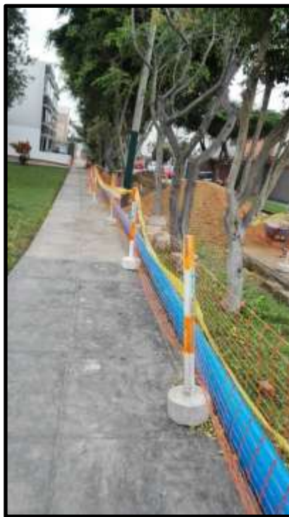
Figura Nº 08: instalación de redes de agua potable HDPE en la Urb. Micaela Bastidas en el Distrito de Los Olivos
