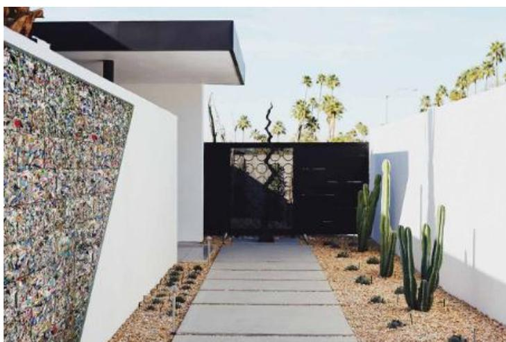
**Figura N°107:** Empleo del ByBlock en construcción de muros.
