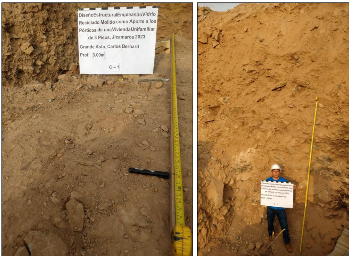
Profundidad de excavación de calicatas C-1.
