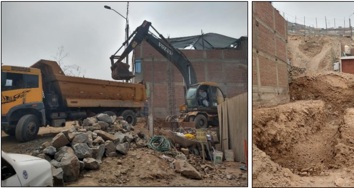
Excavación con maquinaria pesada en la zona de estudio.
