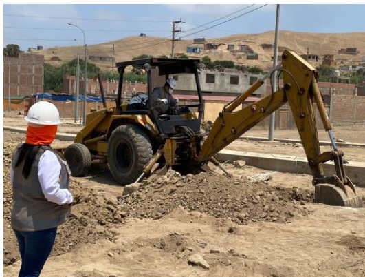
Figura 5. Realización de la C-1 con excavadora
