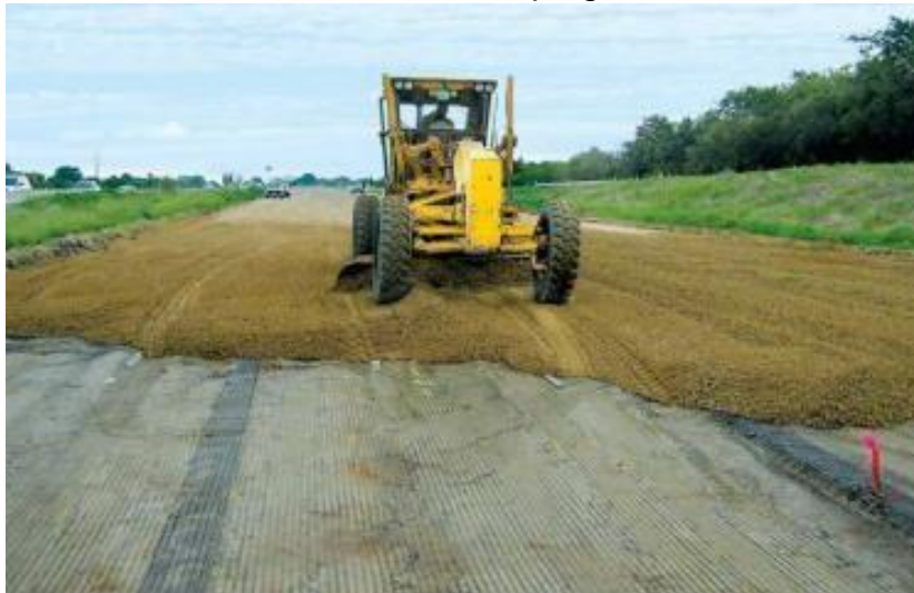
Nivelación de capa granular
