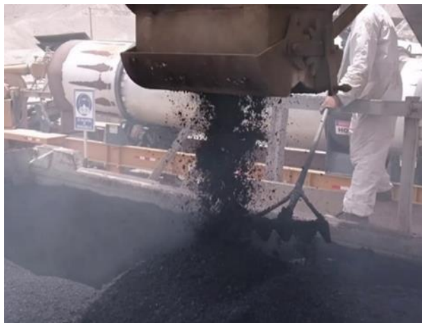
Figura 2. Mezcla asfáltica en caliente
