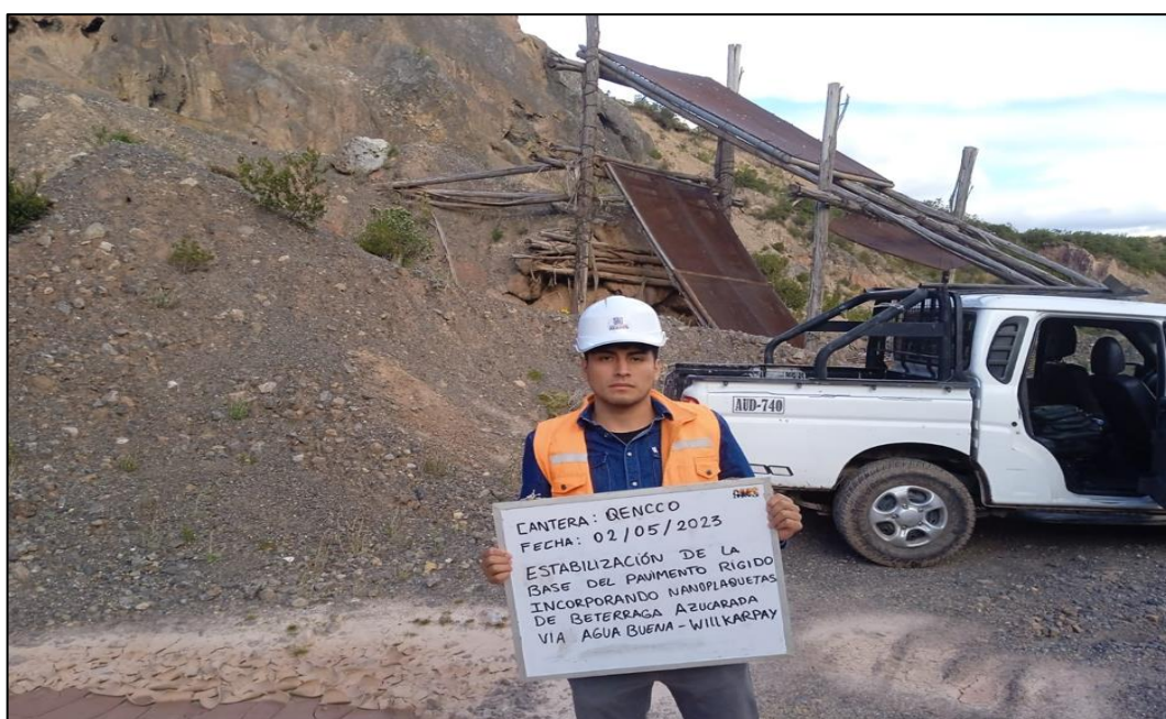
Figura 7. Extracción de material de cantera
