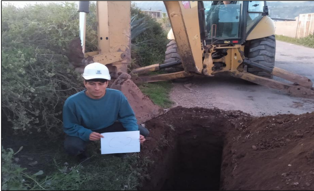
Figura 9. Extracción de material – calicata C2
