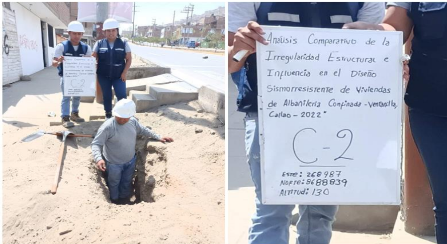
Figura 11. Extracción de muestra de Calicata 02
