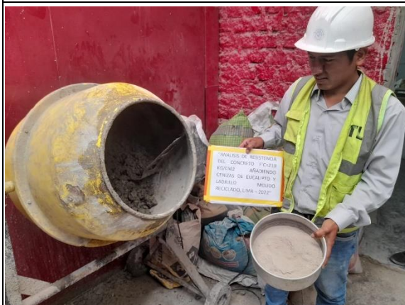
Imagen 27. Elaboración del concreto añadiendo 7% de cenizas de eucalipto. Fuente: Elaboración propia.
