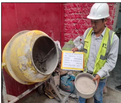
Figura 12. Elaboración del concreto añadiendo 7% de cenizas de eucalipto.
