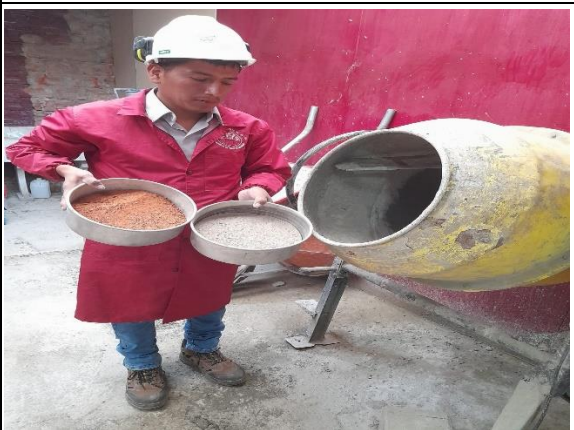
Imagen 28. Elaboración del concreto añadiendo 7% de ceniza de eucalipto y 10% de ladrillo molido reciclado de arcilla. Fuente: Elaboración propia.
