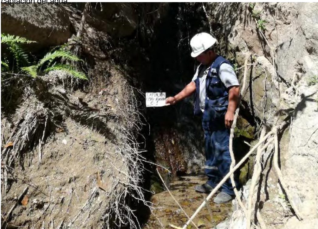
captación del agua
