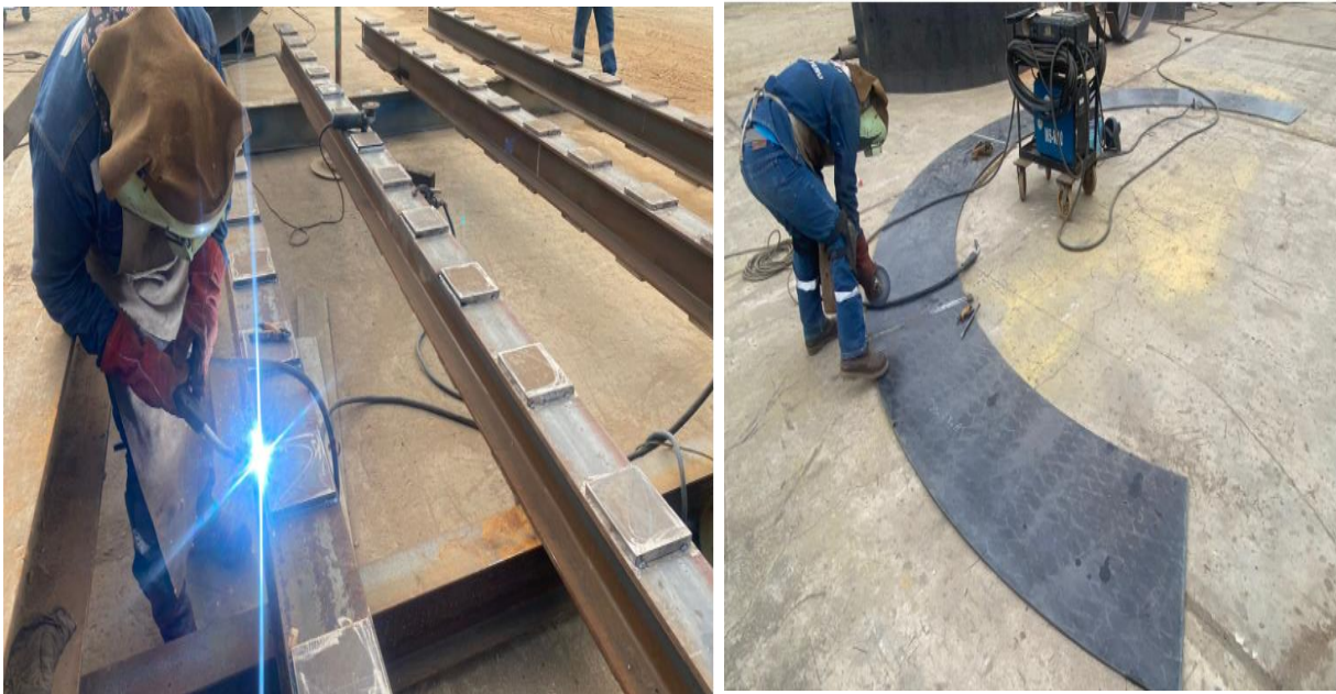
Figura 15 Proceso De Soldadura FCAW
