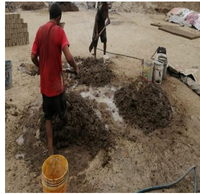
Batido de la mezcla con palana, después de las 24 horas.
