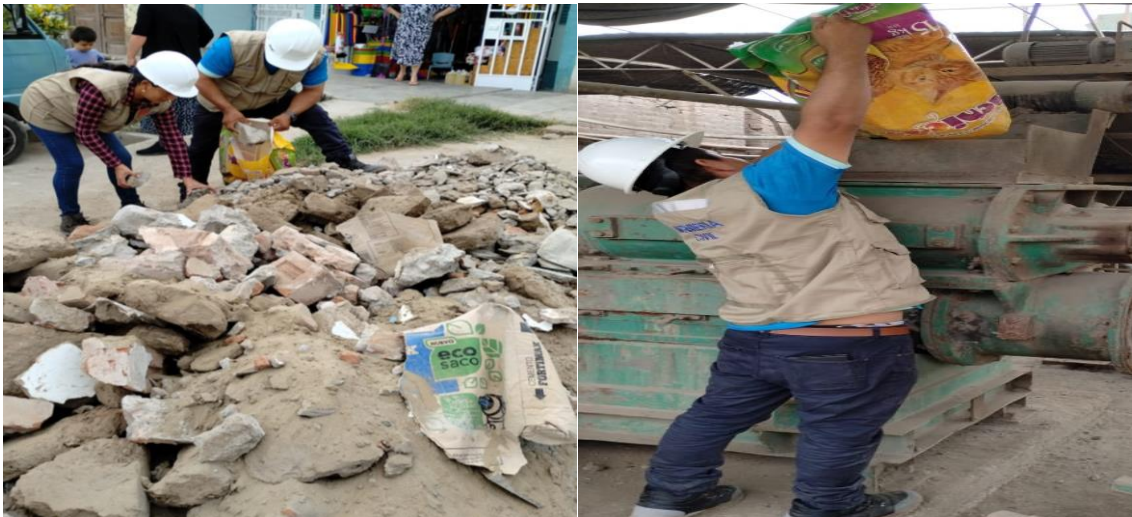
Imagen N°2: Recolección y trituración del concreto reciclado.
