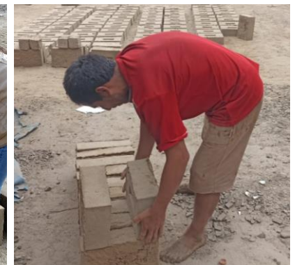
Después de secar 28 días, se procede a juntar los adobes en filas de uno sobre otro.
