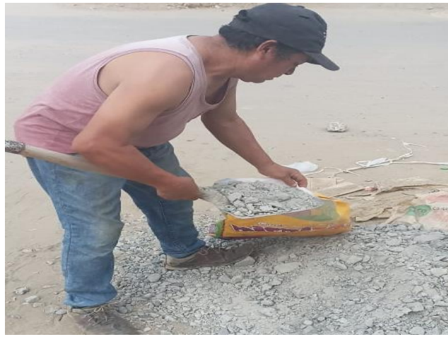
Reciclado de concreto de falso piso demolido.
