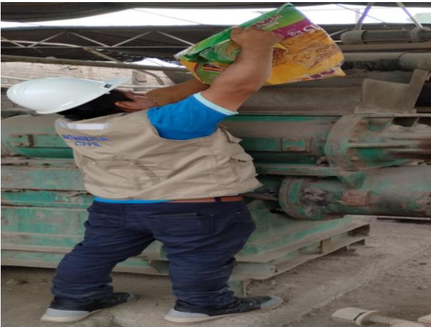
Trituración del concreto reciclado.
