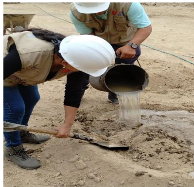
Mojado de la mezcla por 24 horas, para uniformizar la humedad en las partículas.
