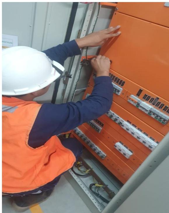
Figura 12: Colocación de tapa interna del tablero.
