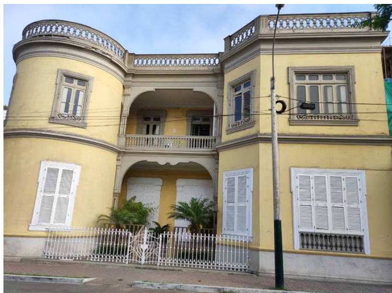
Figura 5: Vivienda multifamiliar Sáenz Peña 02, ubicado en el distrito de Barranco, departamento y provincia de Lima.
