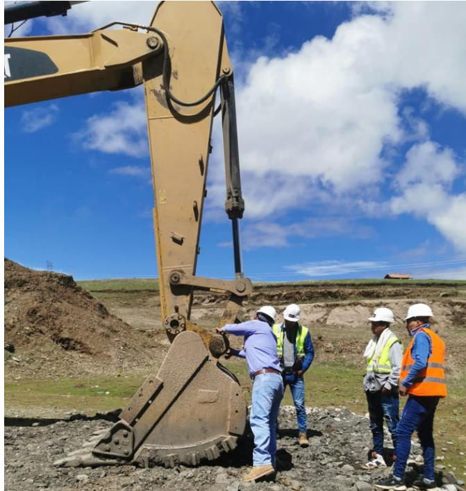
Figura 16. Inspeccionando componentes como parte del Plan propuesto
