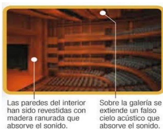
Figura 51. Materiales de la Sala Principal del Gran Teatro Nacional del Perú. Fuente: https://www.proyectosapp.pe/RepositorioAPS//0/2/JER/PC_GTN/PPT_GTN_ESP___ACT_21_08.pdf
