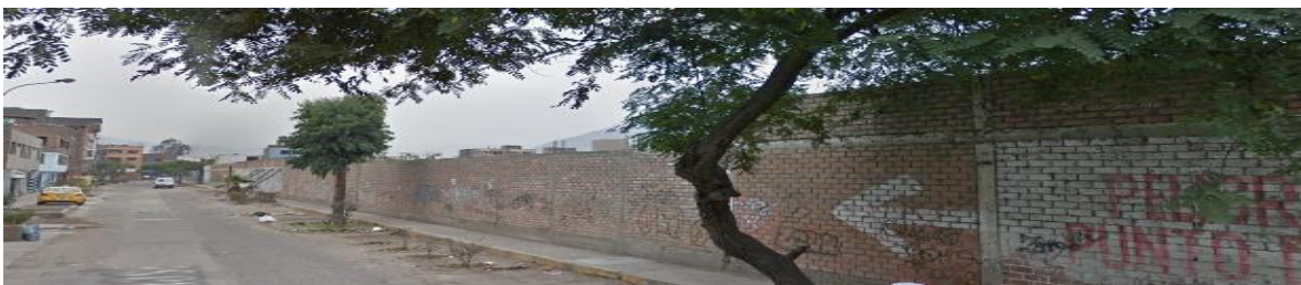
Figura 38. Imagen Lateral del terreno Calle Yachayhuasi. Fuente: Google Maps.
