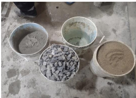
Materiales para el concreto.
