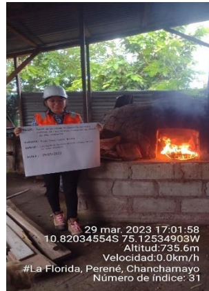
Calcinación de los materiales a adicionar
