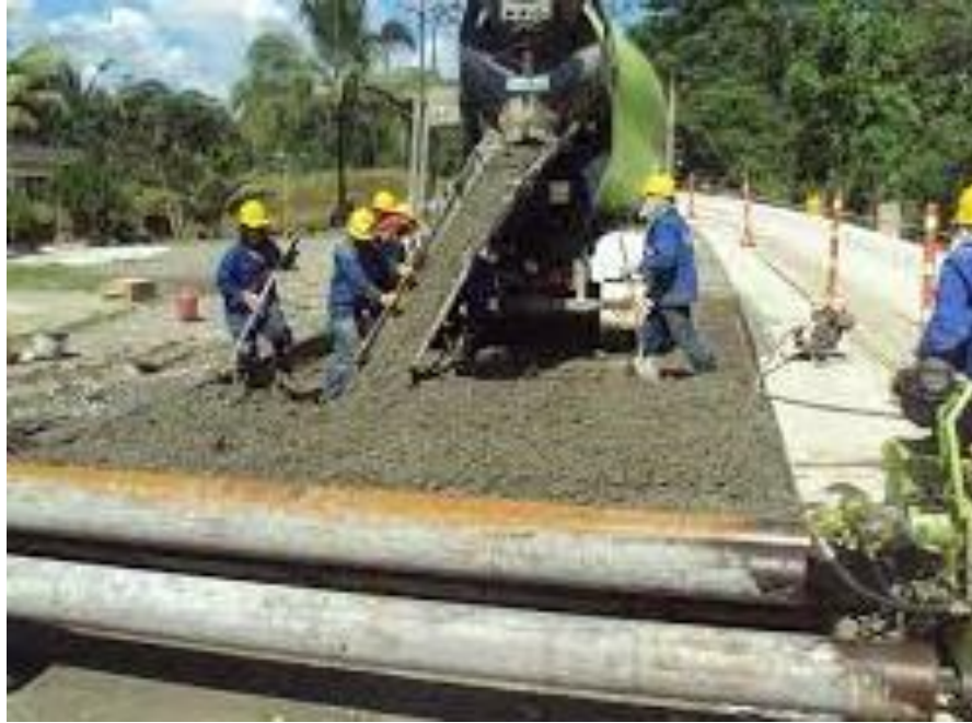
Figura 5. Concreto reforzado con fibras de acero
