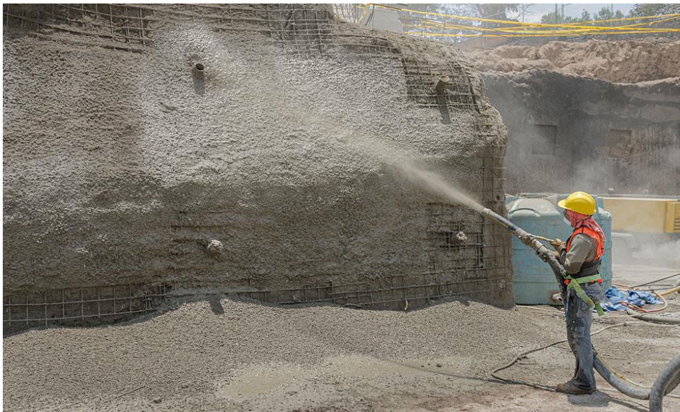
Figura 6. Concreto proyectado o Shotcrete
