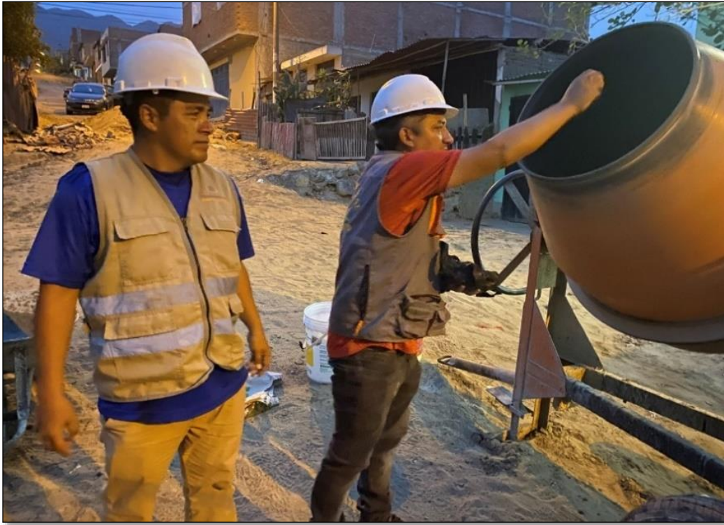
Fotografia 5. Adicion de la fibra alambre galvanizado a la mezcla de concreto.
