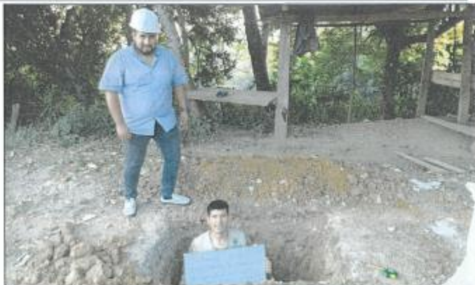
Imagen N° 02: Se aprecia el Perfil estratigráfico y tipo de suelo, la cual se registró al realizar la excavación en la Calicata 01.
