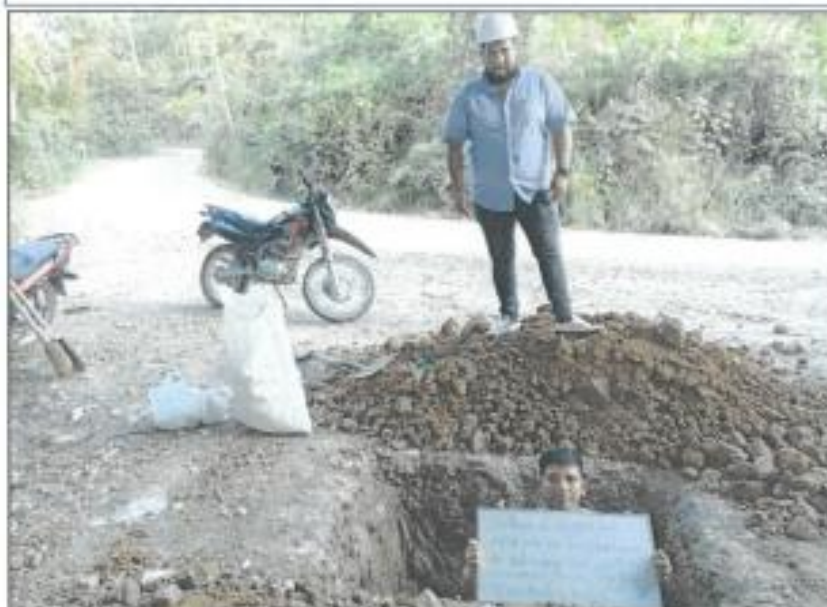
Imagen N° 06: Se aprecia el Perfil estratigráfico y tipo de suelo, lo cual se registró al realizar la excavación en la Calicata 03 .
