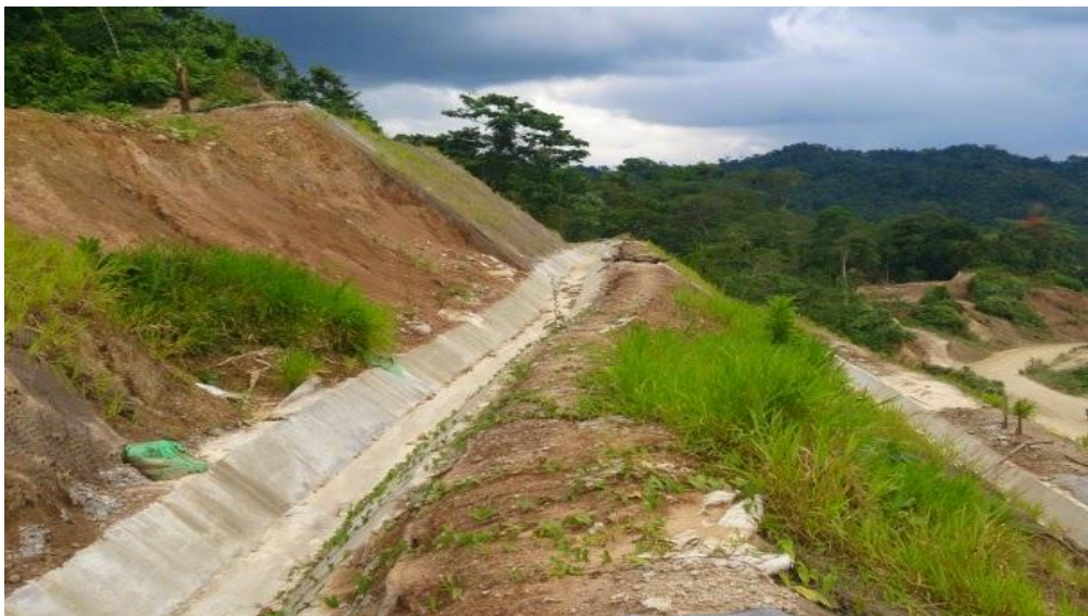
Figura 3: Cunetas de coronación
