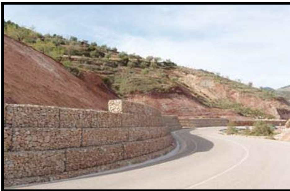
Figura 4: Muros de gavión
