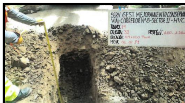
Figura11. Excavación de calicata
