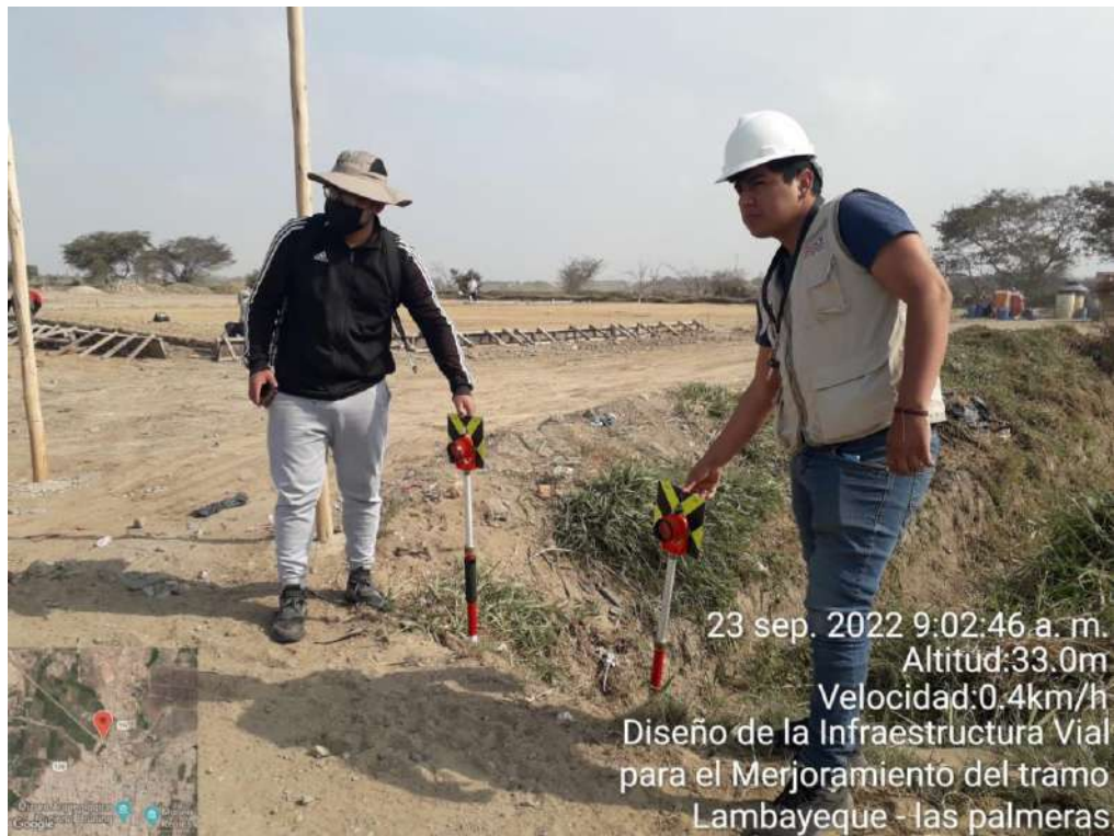
Figura 7. Toma de puntos en el dren para el levantamiento topográfico.
