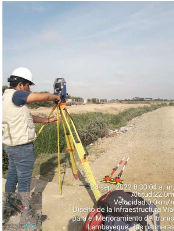
Figura 3. Se evidencia trabajos de estudios básicos - Topografía.
