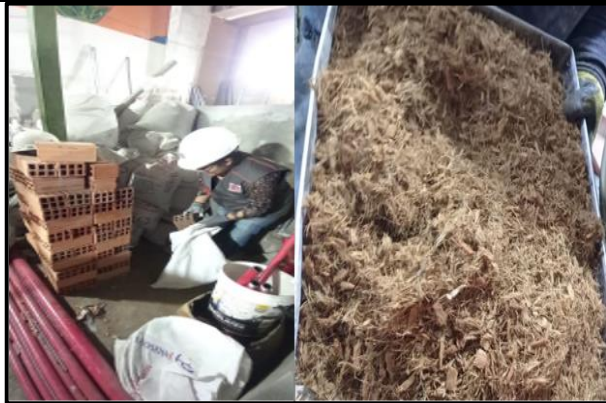
Fotografía 1. Adquisición de los materiales
