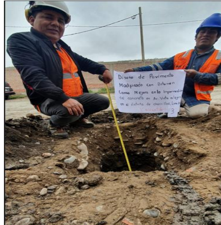
Figura 10. Imagen de la calicata 3 – profundidad de 1.50 m. Fuente. Elaboración propia.
