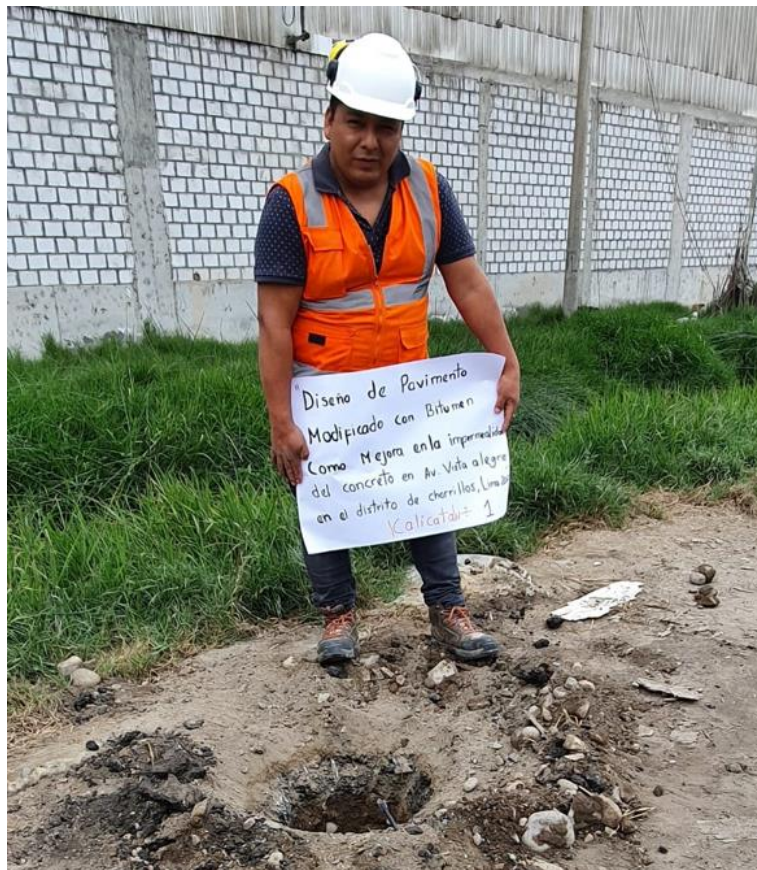
Figura 8. Imagen de la calicata 1 – profundidad 1.50 m. Fuente. Elaboración propia.
