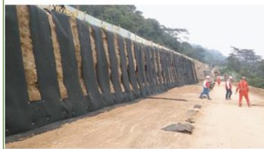
Figura 3. Especificaciones técnicas del geodrén planar
