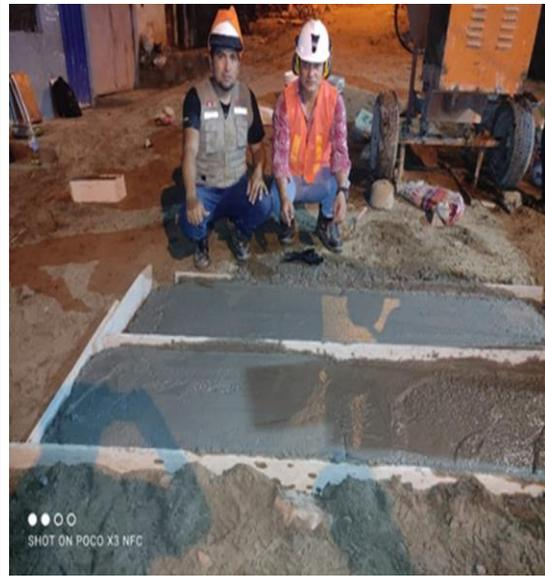
Proyecto vaciado: concreto patrón 1 y concreto con 40% de remplazo de AGR por AGN 2
