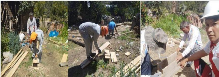
Figura 34. Proceso del armado del encofrado
