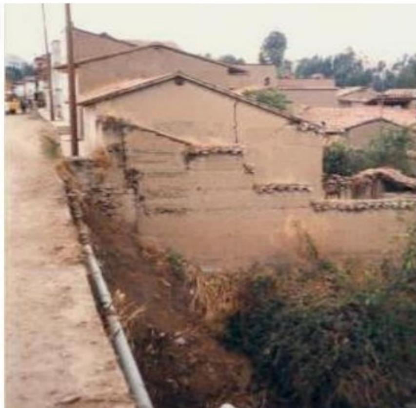
Figura 9. Falla estructural en muros de tapial, ININVI (2016).
