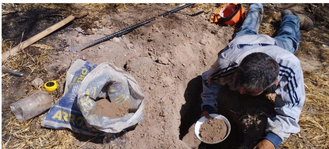
Figura 14: Extracción de material tierra para tapial 20 kg.
