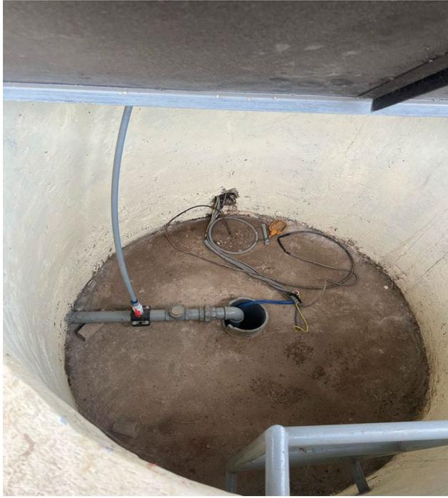
Fotografía 7: Fuente de extracción agua potable.
