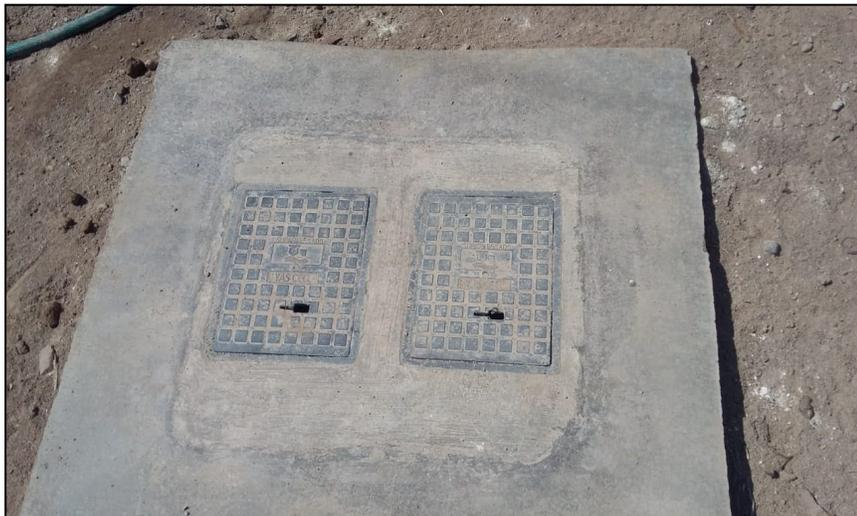
Fotografía 4: Vista de conexiones domiciliarias de agua existentes.
