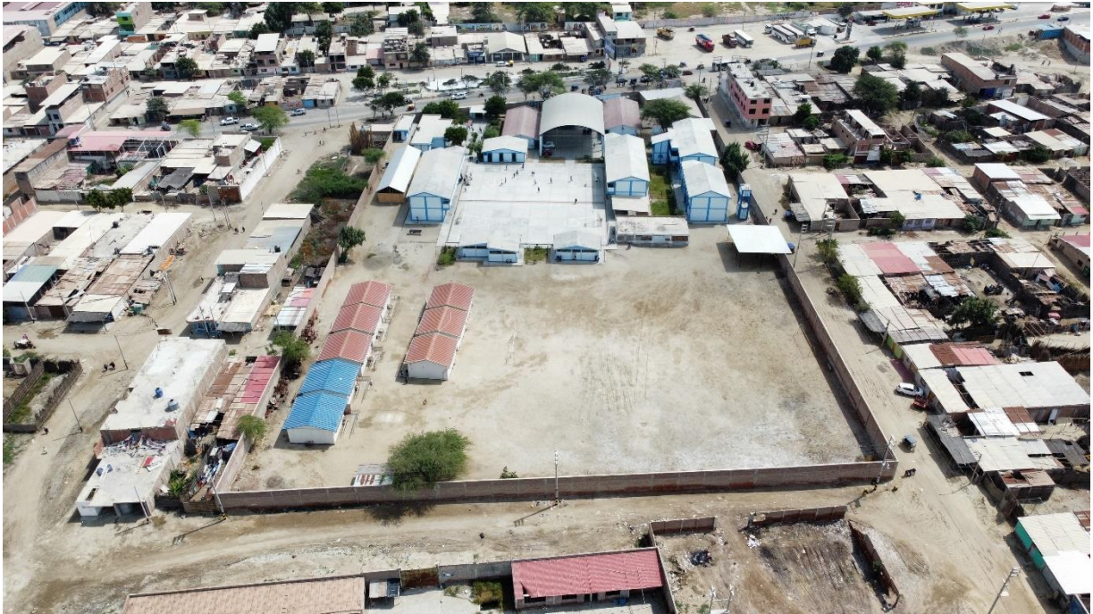
Figura 6. Vista aérea del local de la I.E. Libertadores de América ( (Elaboración Propia, 2023)
