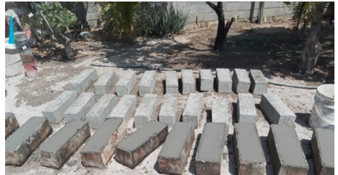
Elaboración de vigas
