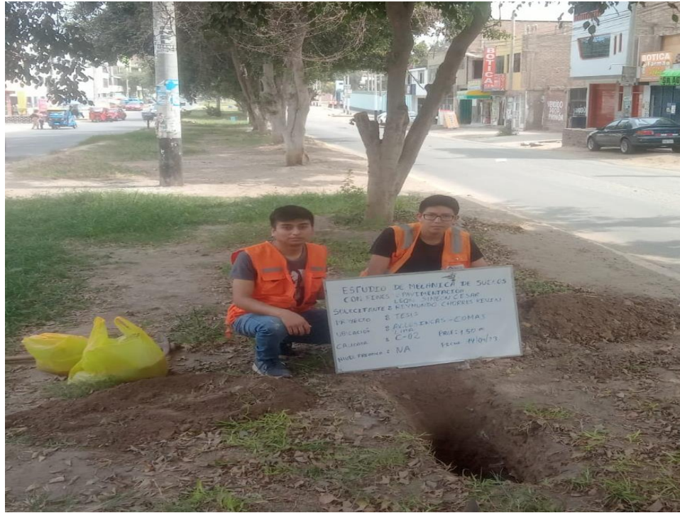
Figura 15. Excavación del terreno a evaluar – Calicata (02) Fuente: Imagen referencial, elaboración propia
