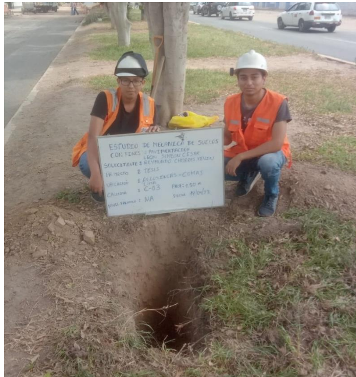
Figura 17. Excavación del terreno a evaluar – Calicata (03) Fuente: Imagen referencial, elaboración propia
