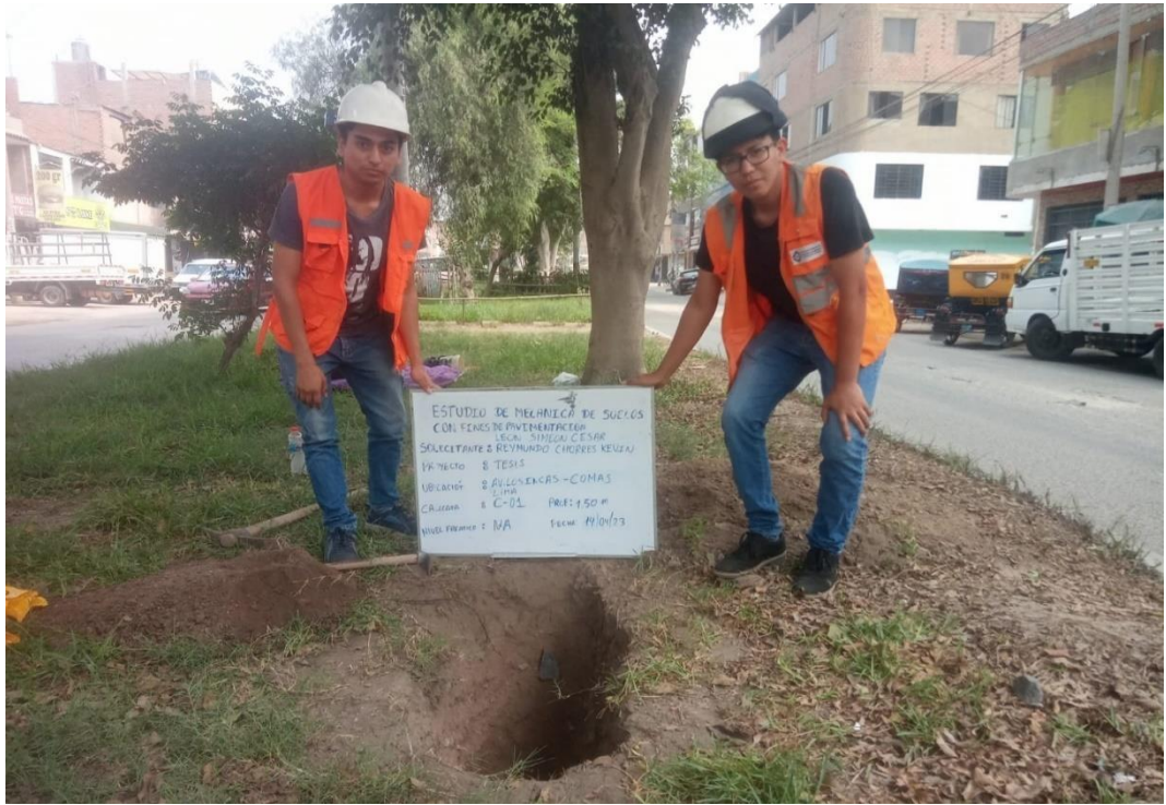
Figura 13. Excavación del terreno a evaluar – Calicata (01) Fuente: Imagen referencial, elaboración propia
