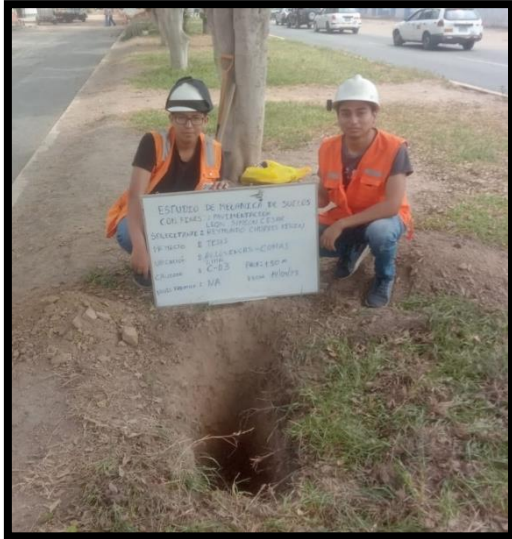
Foto 3: Excavación calicata 03
