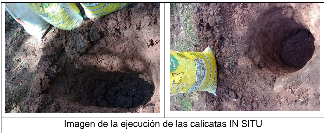
Figura 5. Ejecución de las calicatas IN SITU
