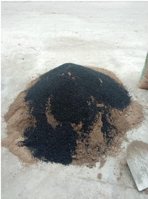
1) Preparación de mezcla
