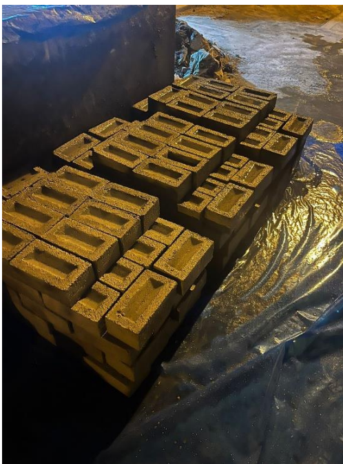
3) Curado de ladrillos
