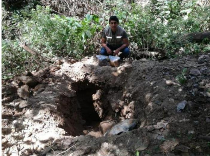
*Ilustración 11 excavación de calicata N°2*
