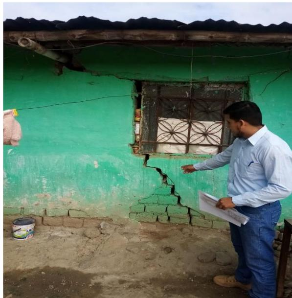
**Figura 06** Cimentación y muro de vivienda deteriorado con fisuras interiores y exteriores mayores a 3mm
