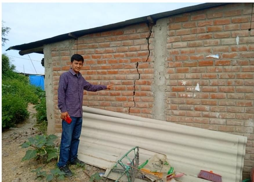
**Figura 02:** Muros de la vivienda con fisuras exteriores mayores a 2mm
