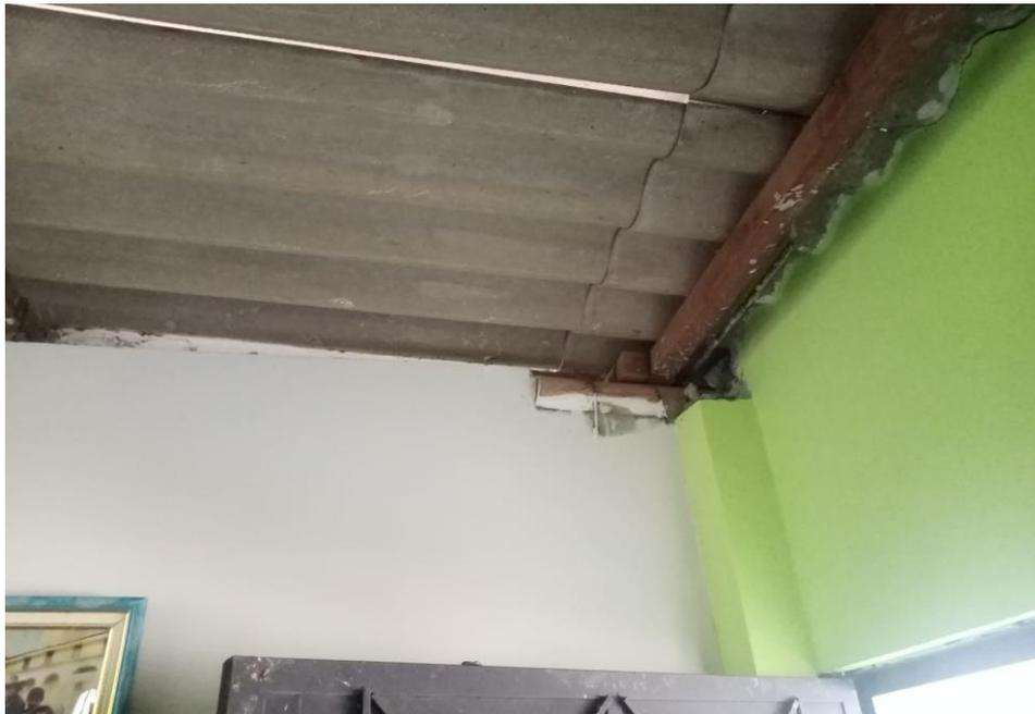
**Figura 11:** Malas conexiones entre columna, muros y cubierta
