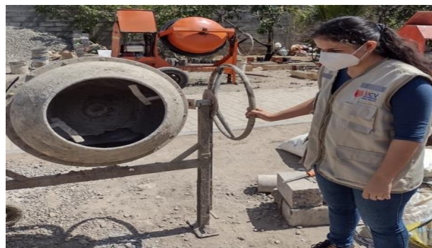
Figura 14. Mezclado del concreto, para posterior vaciado.
