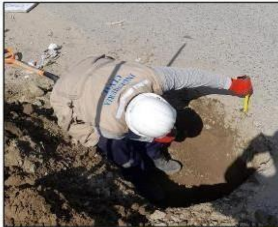
FOTO 03: SE OBSERVA LA EXCAVACIÓN CALICATA C-02.
