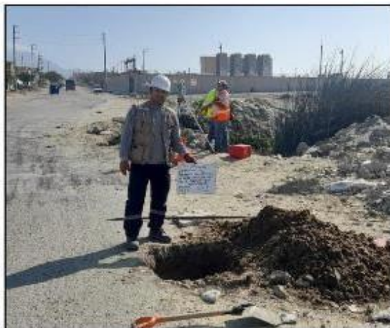
FOTOS 02: SE OBSERVA UNA VISTA PANORÁMICA DE LA EXCAVACION DE LA CALICATA C-01.
