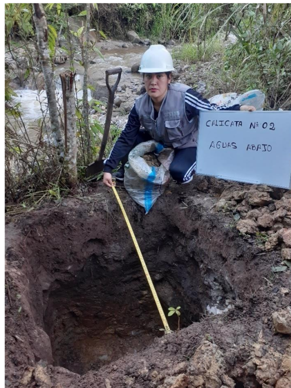
Foto 7: Vista de extracción de material calicata N° 02 aguas abajo de la quebrada Cristalina
