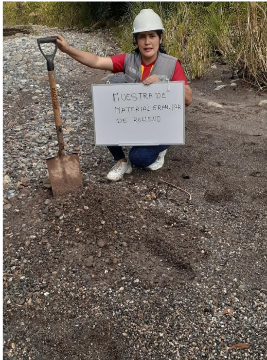
Foto 10: Muestra de material granular para rellenos
