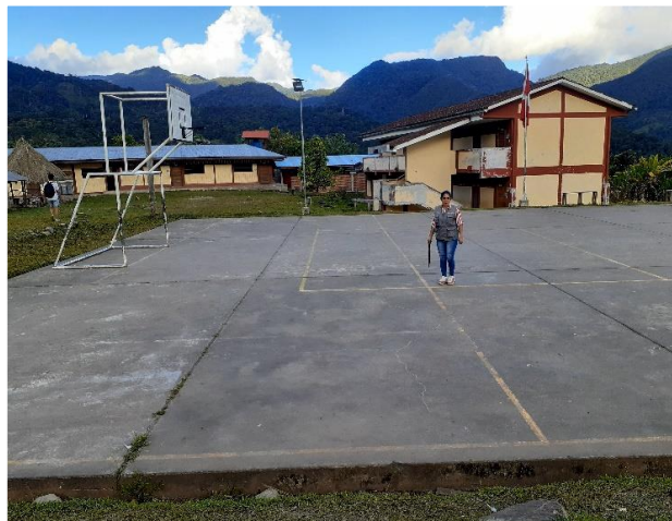
Foto 34: Losa deportiva en riesgo de inundación en la localidad el Líbano
