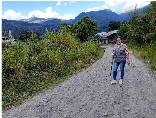
Foto 38: Infraestructura vial en la localidad el Líbano en riesgo de inundación
