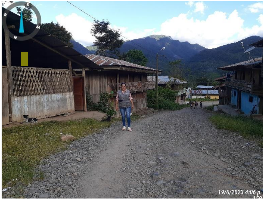
Foto 35: Viviendas en riesgo de inundación localidad el Líbano
