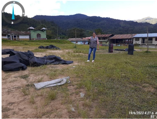
Foto 37: Vista de zona de plaza de armas en riesgo de inundación
