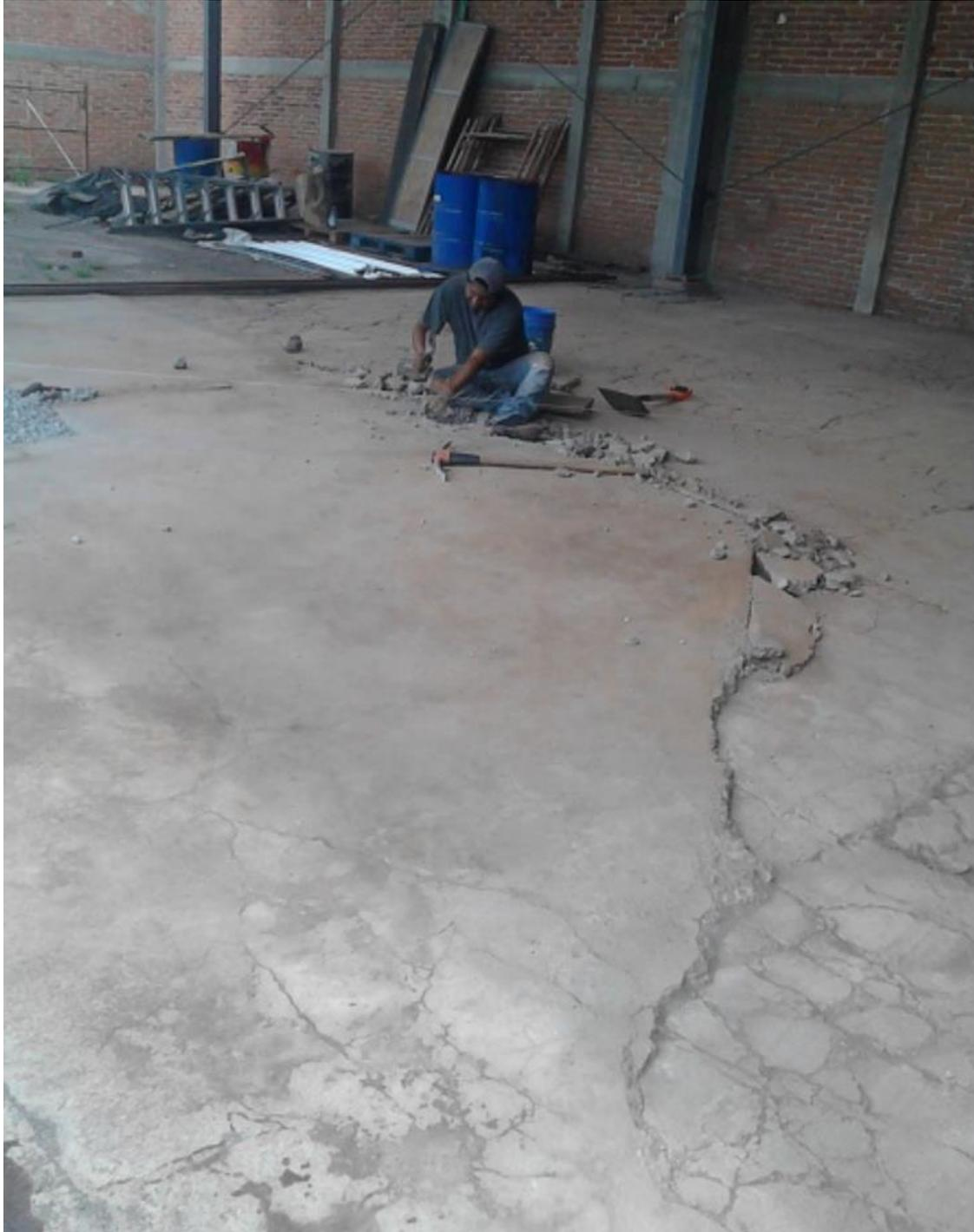
*Figura 17* Pisos agrietados y desnivelados
