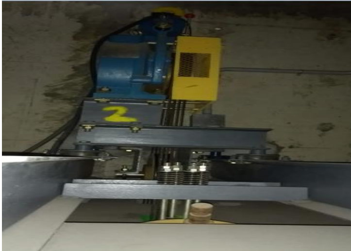
FIGURA 3. Mantenimiento preventivo del sistema de freno
