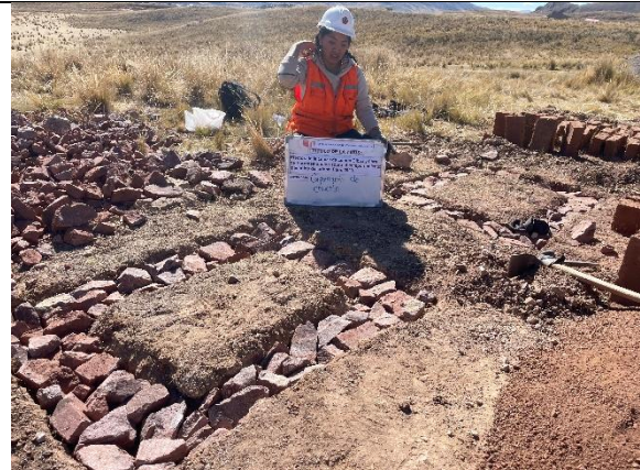
Fotografía 58. Conformación de los cimientos
