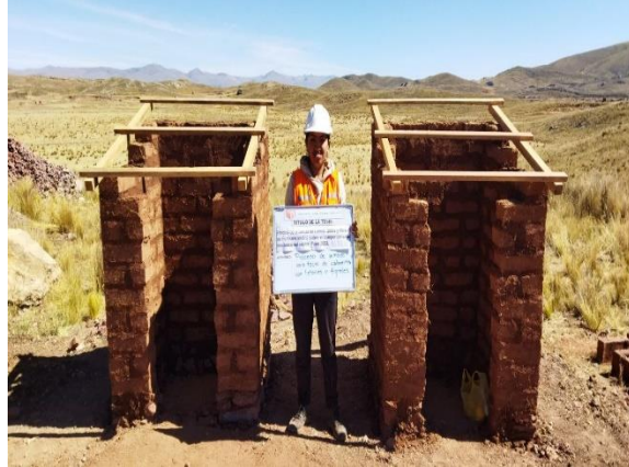
Fotografía 61. Proceso constructivo de los módulos de adobe
