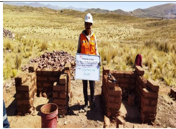
Fotografía 60. Proceso constructivo de los módulos de adobe
