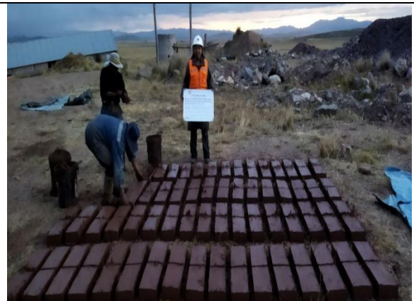
Fotografía 34. Fabricación de las unidades de adobe
