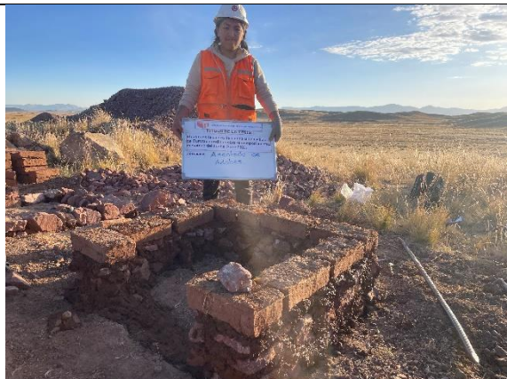
Fotografía 59. Conformación del sobrecimiento
