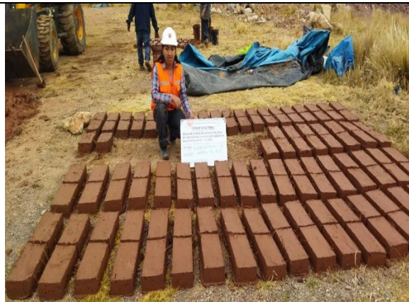
Fotografía 33. Fabricación de las unidades de adobe
