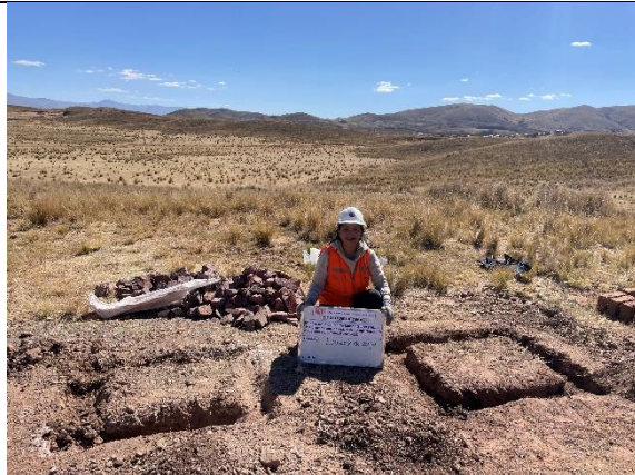
Fotografía 57. Excavación de los cimientos
