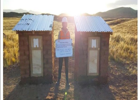
Fotografía 62. Proceso constructivo de los módulos de adobe
