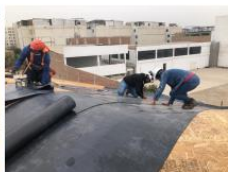
En los techos ondulados están trabajando en los últimos detalles y han empezado con la cubierta de caucho-EPDM.
