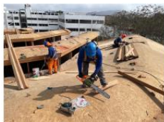
En los techos ondulados están trabajando en los últimos detalles y han empezado con la cubierta de caucho-EPDM.
