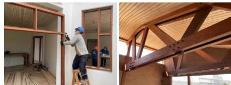
Instalando los marcos de las ventanas y puertas mientras se terminan los techos acústicos en ambos pisos.
